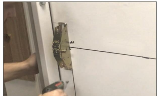
**10.** С противоположной стороны установить вторую часть механизма. Саморез №1 (4 шт.).
