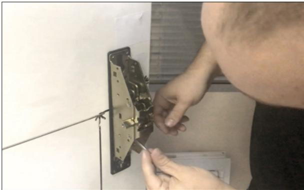
**8.** Установить второй винт M5x55 мм со втулкой M5x40 мм. Отверстие над цилиндром. Таким образом нажимной механизм будет притянут к полотну.
