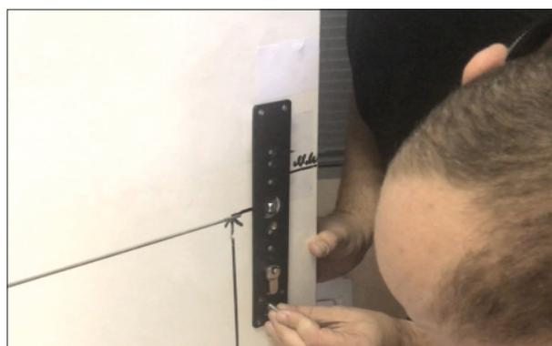
5. С внешней части полотна установить нажимную ручку. По цилиндру установить монтажную пластину. Винтом М5х55 мм со втулкой М5х40 мм скрепить ручку с монтажной пластиной с внутренней стороны через нижнее отверстие.
