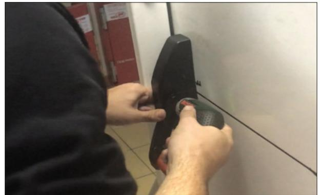
**17.** Установить балку с рычагами на механизмы. Зафиксировать рычаги. Винт №1 (2 шт.).
