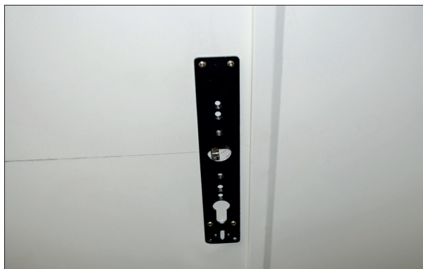
7. Закрепить монтажную плату на полотне двери. Использовать саморез №1 (4 шт.).
