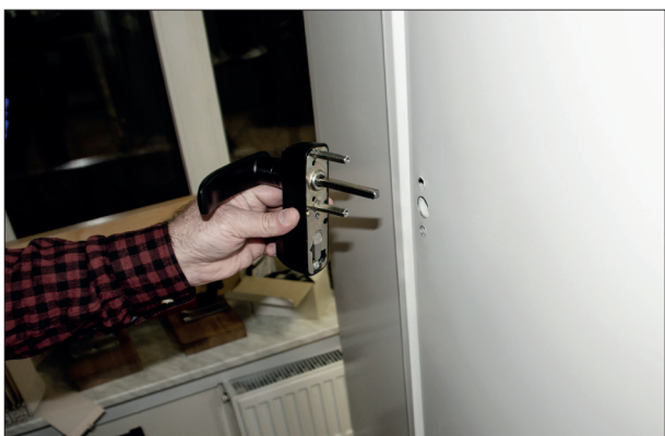
8. Установить ручку с обратной стороны двери (см. инструкцию по сборке и монтажу ручки).
