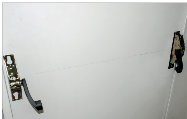
13. Установить нажимные рычаги. Закрепить их винтом №3 (2 шт.).
