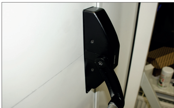
19. Установить кожухи на механизмы. Использовать винт № 4 (4 шт.).
