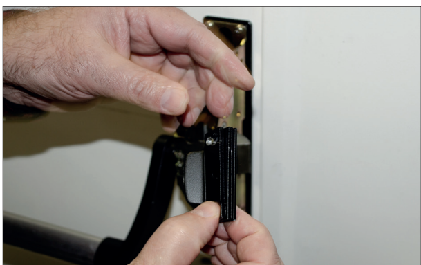
18. Установить ответную планку приводного механизма. Количество прокладок по-необходимости. Закрепить саморезами №7 (2 шт.) через крайние отверстия. Отрегулировать. Зафиксировать через центральное отверстие саморезом №7.
